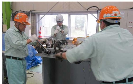
図-3 ボルト締め付け時の状況
