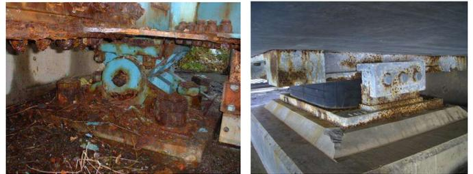
図-1 支承部の発錆事例 (日本国内橋梁での例)
