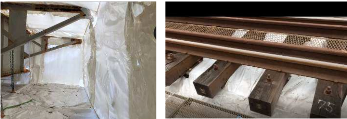
写真-3 プラスト養生状況
