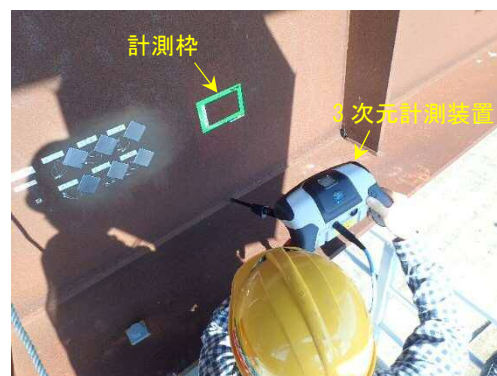
写真-1 3 次元計測状況
