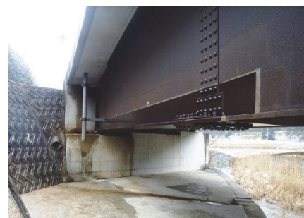
写真1 山根橋補修塗装完了後外観
