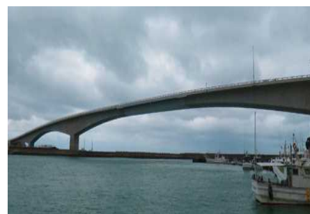
図6. 開発鋼が適用された橋梁
