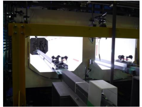
図5 カルバート内空の撮影状況
