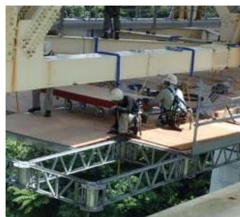
図-5 足場組立状況
