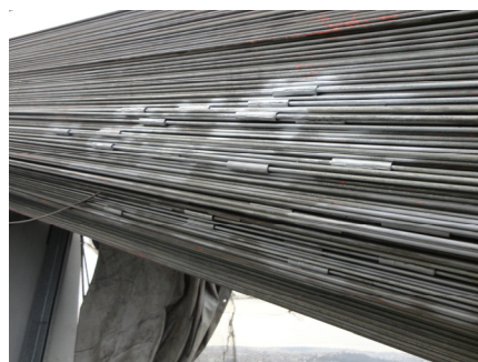
図2 素線の応急処置状況
