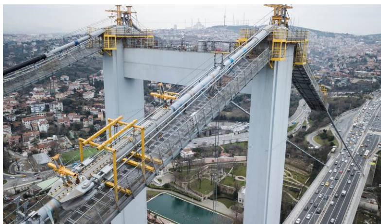
図7 主ケーブル補強施工状況
