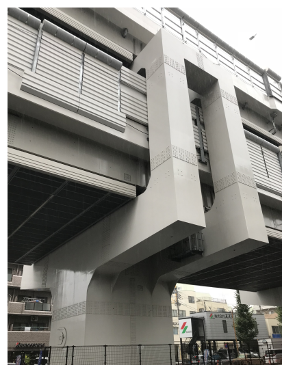
写真-1 ダブルラケット型橋脚の完成
