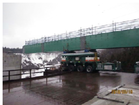
写真-2 側径間架設
