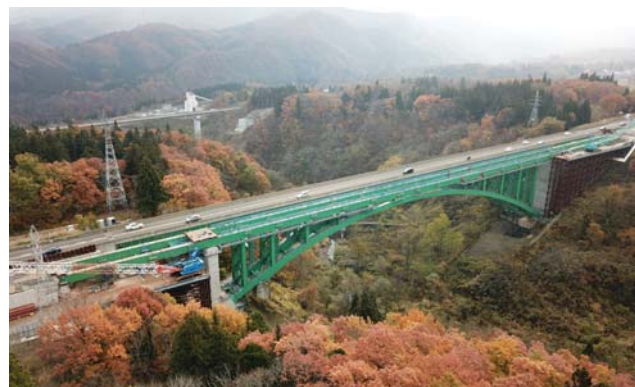
写真-4 架設完了(Ⅱ期線側より)
