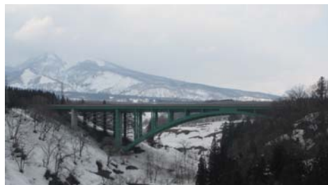
写真-1 I 期線側より撮影
