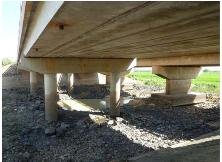
写真-1 下部工形式の相違 (左：中国施工，右：日本施工)
