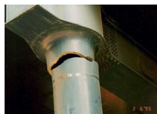
写真-1 鋼製橋脚の破壊 写真-2 圧縮による破壊
