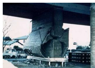
写真-1 鋼製橋脚の破壊 写真-2 圧縮による破壊
