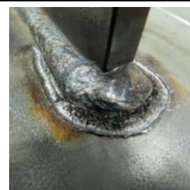
写真-2 UIT 施工後の形状
