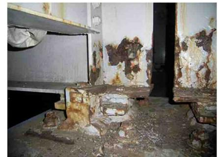
写真-2 桁端下部の腐食事例
