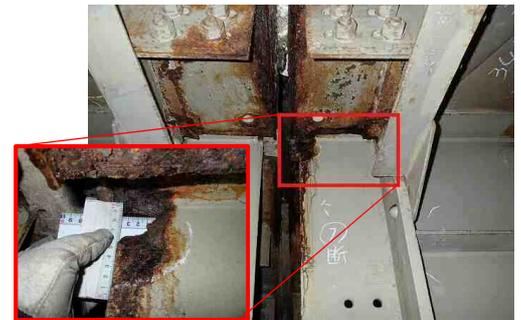
写真-1 桁端上部の腐食事例
