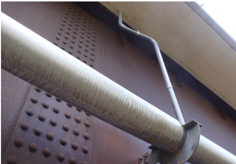
写真-3 導水管設置状況
