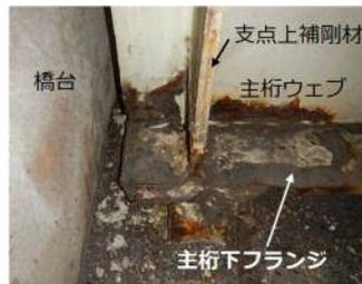
写真-1 腐食損傷状況
