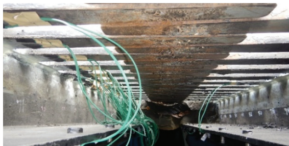
写真-1 ひずみゲージ貼付状況
