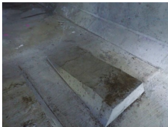
図-2 箱桁内にあるPC鋼材の定着部
