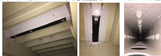
(当板補強「桁内」) 写真-6 鋼床版小補修
