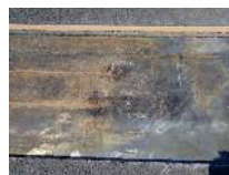
1) 路面開削後 2) デッキプレート上面腐食
