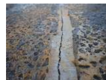
1) 路面開削後 2) デッキプレート上面腐食
