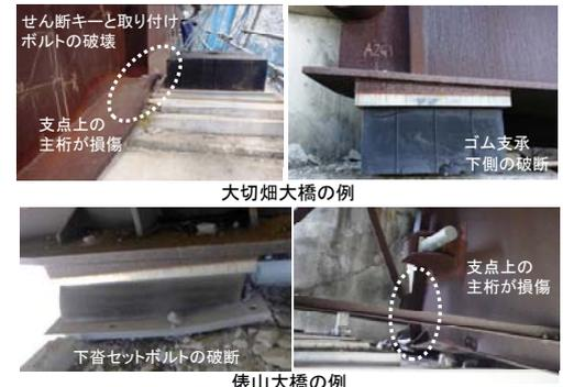
図-1 熊本地震での被災事例
