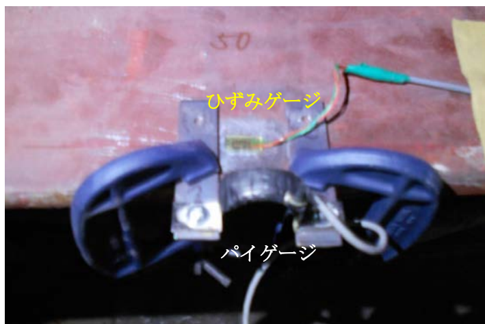
写真-1 パイゲージ(50mm)とひずみゲージの設置状況
