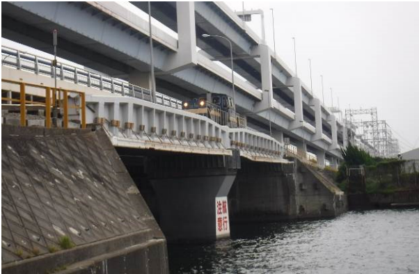
写真-1 浮島橋の全景
