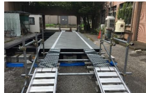
図1 鋼製橋梁外観
