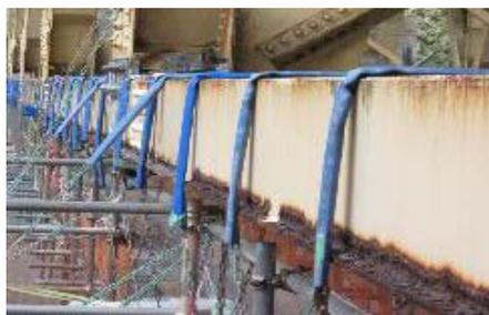
図1 下弦材の腐食事例
