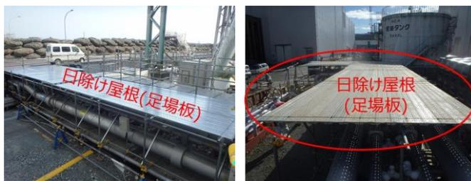
**写真-1 日除け屋根設置状況**
