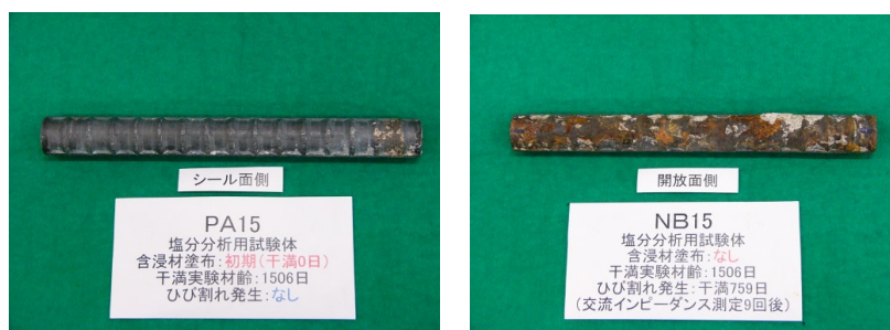
図2 鉄筋の腐食状況（左：含浸材有り、右：含浸材無し）
