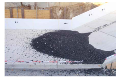
写真-3 平坦部への堆積状況
