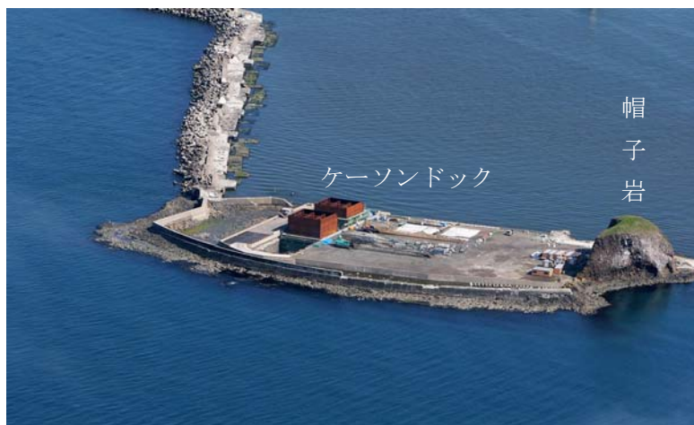
図-1 網走港帽子岩ケーソンドックと北防波堤
