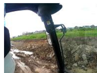
画像 8 施工前状況
