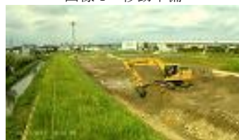
画像 2 整形・掘削
