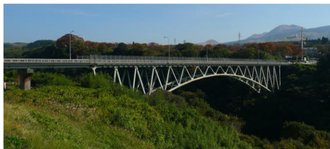
図-1 崩落前の阿蘇大橋
