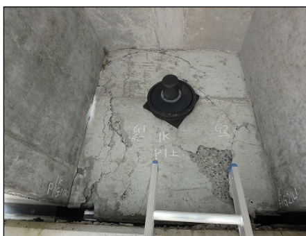
図-4 上部工横桁部(P1支点)
