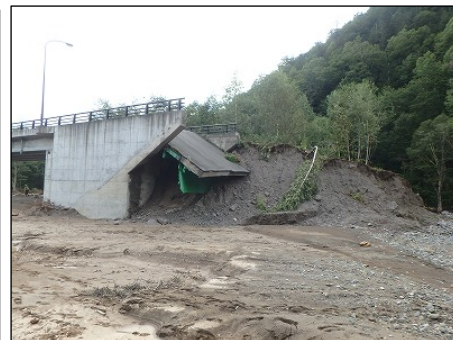
図-5 A2橋台背面
