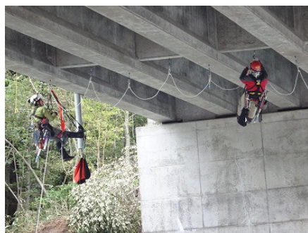
図-6 近接目視確認状況
