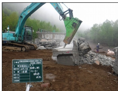
図-11 上部工撤去工事
