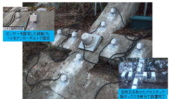
図-5 現場実証試験の設置例
