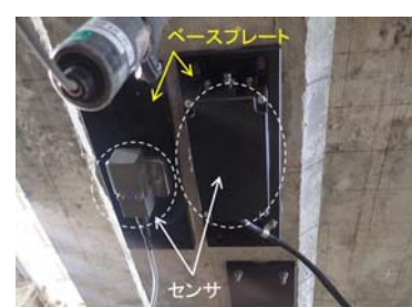
図-3 センサ設置状況
