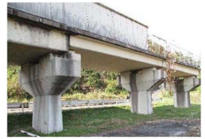
図6 測定対象橋りょう（中央支間）
