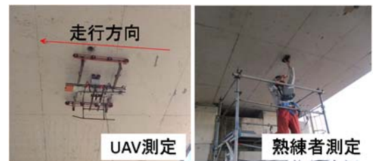
図9 かぶり厚さの測定状況
