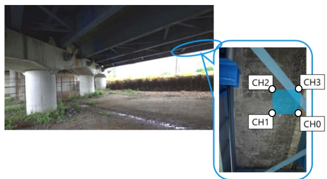
図4 橋梁外観とセンサ設置箇所
