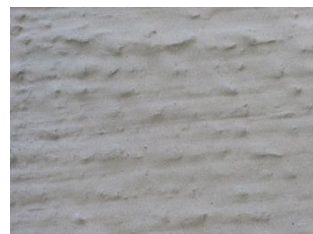
図-2 含浸系防水層施工後の表面状態
