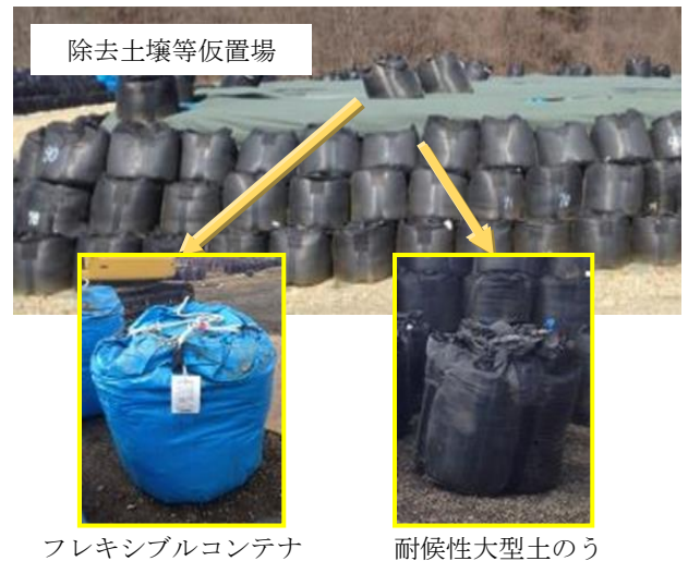
図1 仮置場と保管容器
