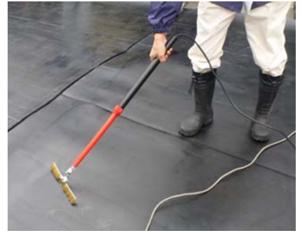
図-4 スパーク検査状況
