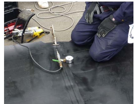
図-2 加圧検査状況
