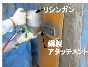
(a) 吹付け状況
