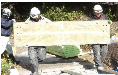
写真-3 パネル人力運搬
