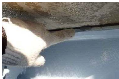
写真-6 接着剤充填確認
