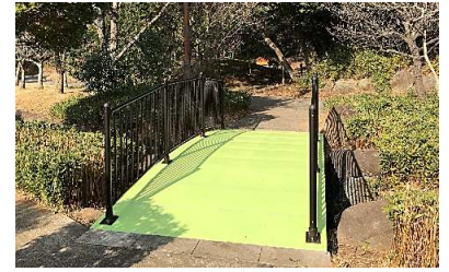
写真-7 完成状況
