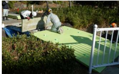
写真-4 パネル仮組
