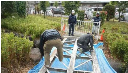
写真-2 桁ケレン
