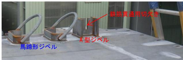
写真-1 鉄道合成桁の桁端部のずれ止め
