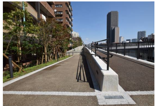
写真-1 橋詰めのスロープ
