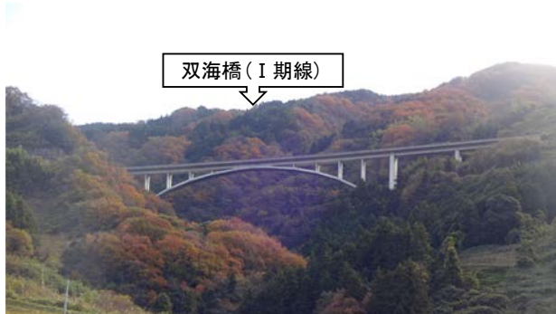
写真-1 I 期線橋梁
