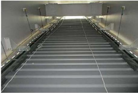
図 3.2 飛来塩分防護板設置事例
