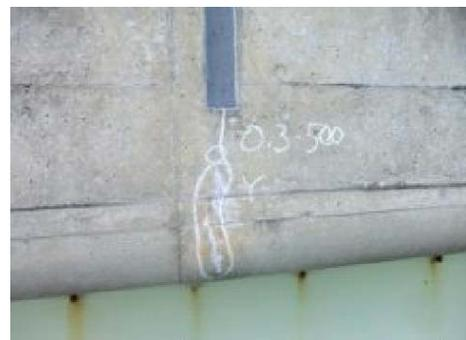
図 4.2 壁高欄目地の遊離石灰事例（県内橋梁）
