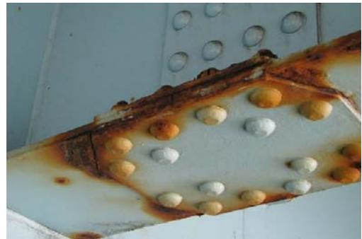
図2.1 ボルト添接部の腐食事例(県内橋梁)
