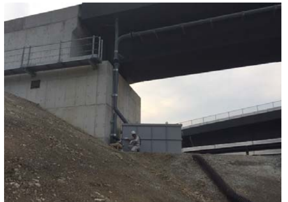
写真-2 路下状況
