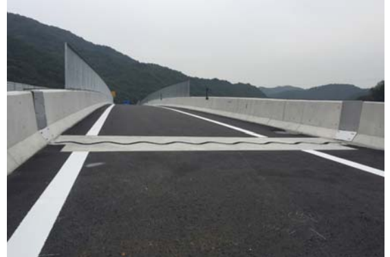
写真-1 橋面状況
