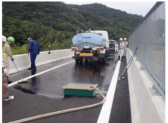
写真-3 散水車による散水状況
