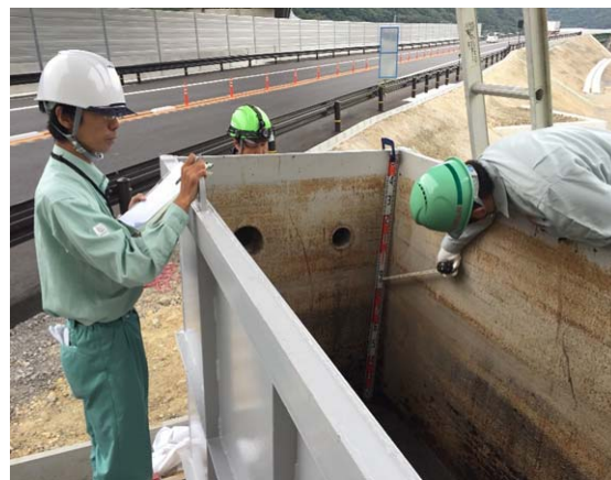
写真-4 排水量測定状況
