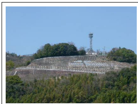
写真-2 花園切土のり面
