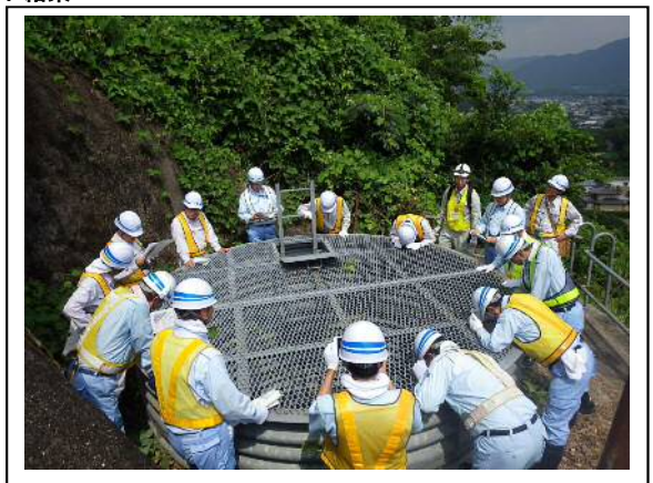
写真-4 地すべり施設の現地調査
