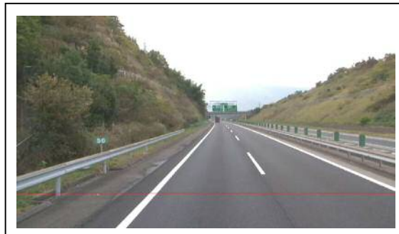
写真-1 川之江切土のり面
