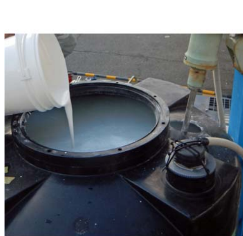
写真-1 微粉末樹脂ペーストの添加状況 図-1 試験サイトの土質性状 図-2 井戸・注入管配置平面図
