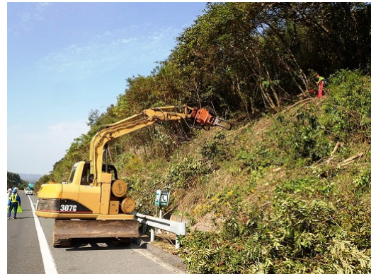
図1 高速道路の維持管理作業の例
